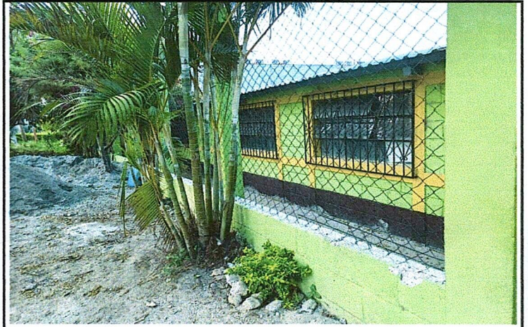
Foto 2: Mejoramiento Muro perimetral
