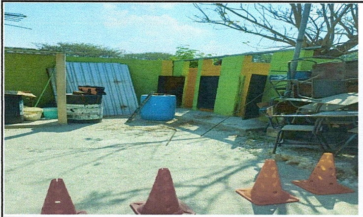
Foto 3: Mejoramiento de baños, piso, techo, azulejo
