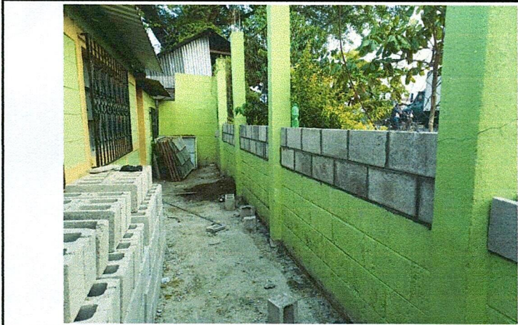
Foto 1: Mejoramiento de Muro perimetral
